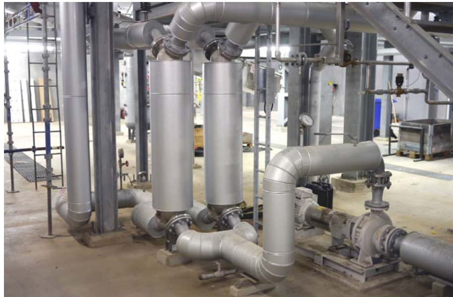
Figur – Exempel på värmeåtervinningsinstallation för nedblåsningstank.
